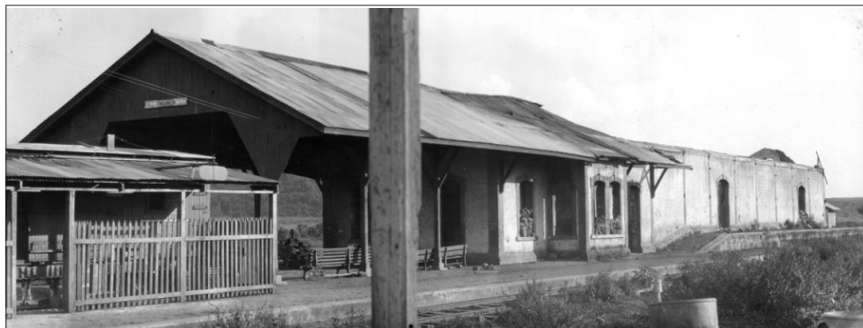
Fig. 5. Frente y lado horizontal del edificio de tabique y lámina (en ruinas) para oficina de la estación con cobertizo de madera y lámina para andén, Tingüindin. 1929.
