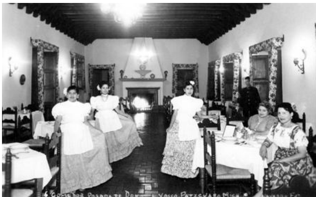
Fig. 7. Estas imágenes y otras provenientes de tarjetas postales permiten entender los cambios en la Posada de Don Vasco a través de las décadas. Fuente: Colección C. Ettinger.
