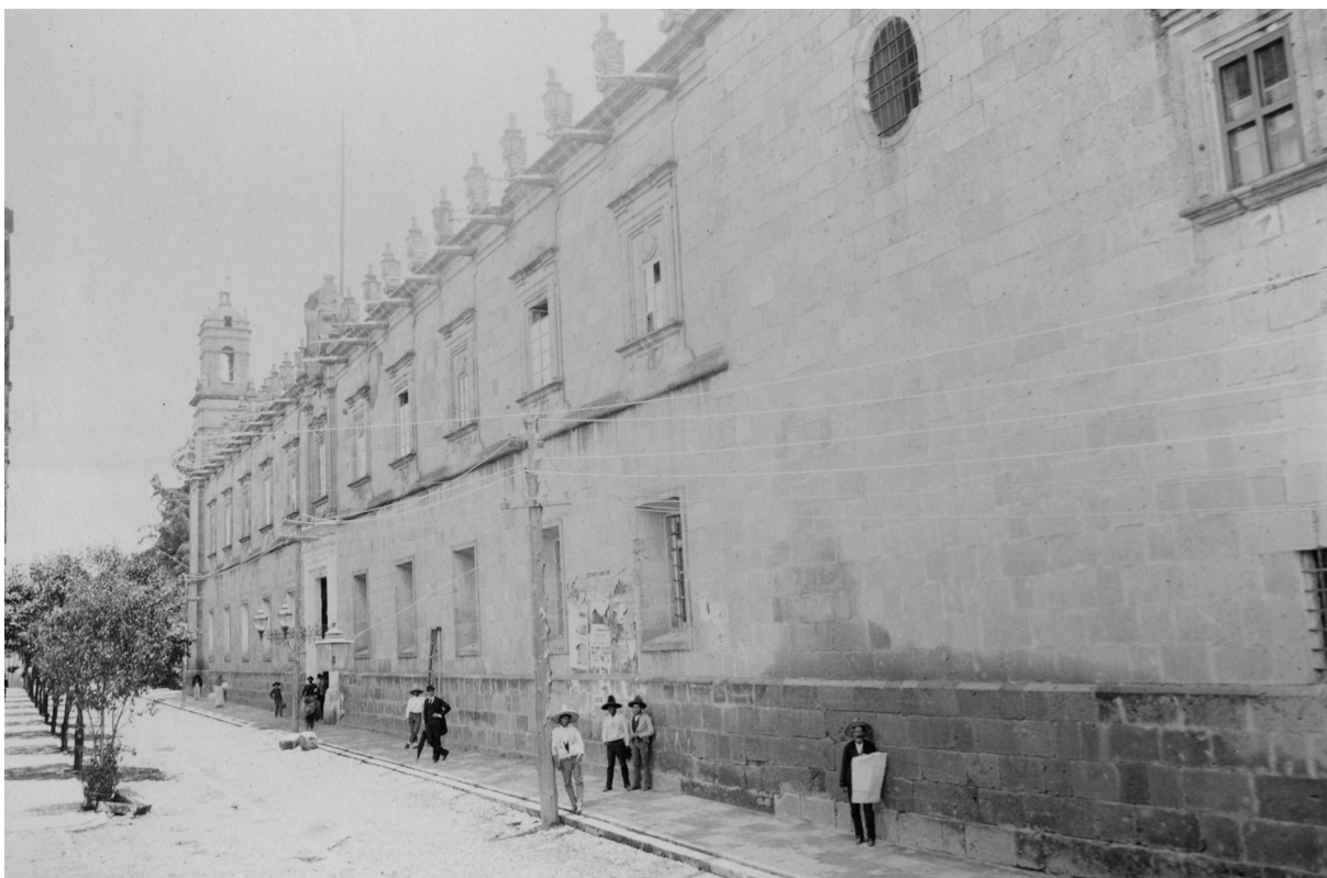
Fig. 3. Fotografía del edificio que albergó a la Escuela de Industria Militar Porfirio Díaz en la ciudad de Morelia, hoy conocido como Centro Cultural Clavijero.
